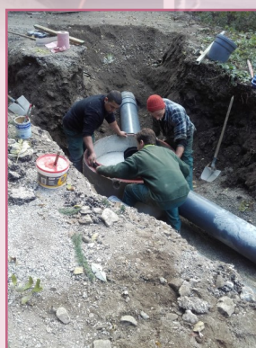
Raccordement de l'usine au réseau eaux usées via le réservoir tampon
