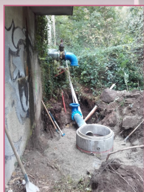
Raccordement de l'usine au réseau eaux usées via le réservoir tampon
