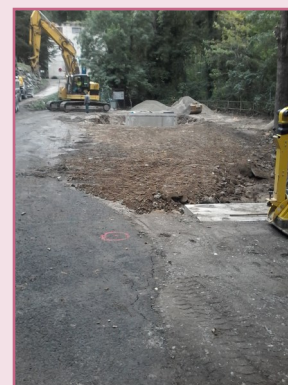
Remblai du réservoir tampon (parking sous station)
