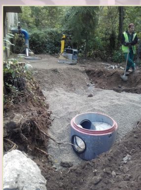
Raccordement de l'usine au réseau eaux usées via le réservoir tampon
