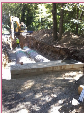
Réservoir tampon des eaux sales de la station avant rejets progressifs dans le réseau d'assainissement de Casteil
