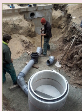
Sortie du réservoir tampon
