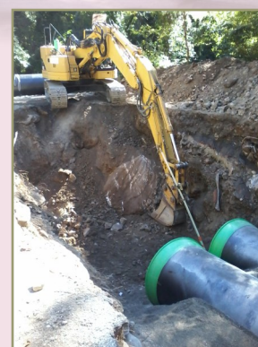
Pose du réservoir tampon
