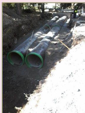
Réservoir tampon des eaux sales de la station avant rejets progressifs dans le réseau d'assainissement de Casteil
